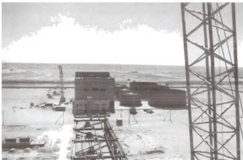
Қўнғирот сода заводи қурилиши
